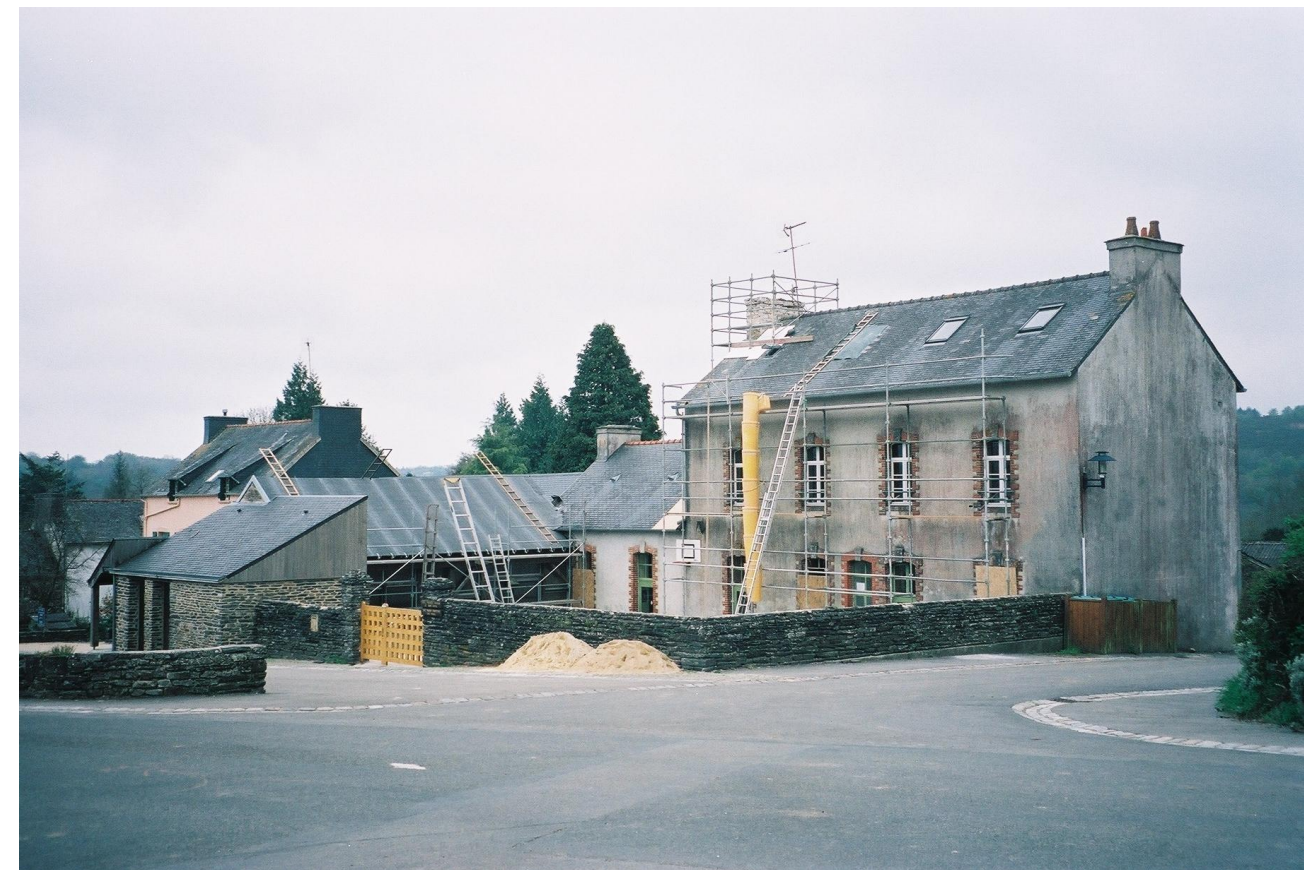
Chantier bras gant Jean jacques Bouguyon evit kempenn an toennoù - Travaux de refecton de toiture avec Jean Jacques Bouguyon
