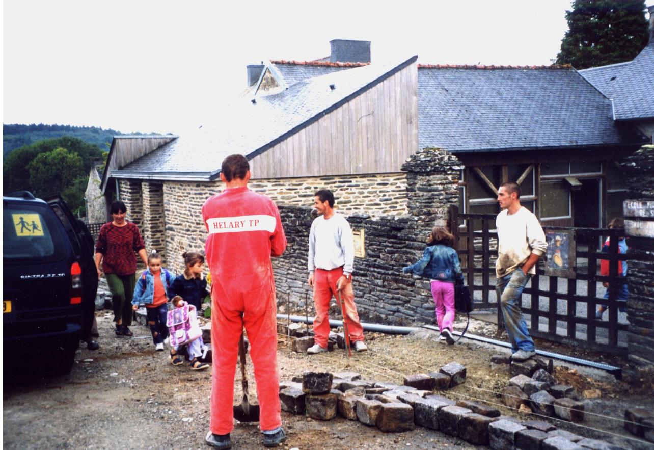
Treuziñ ar chantier evit mont d'ar skol | Rentrée du matin à travers les travaux
