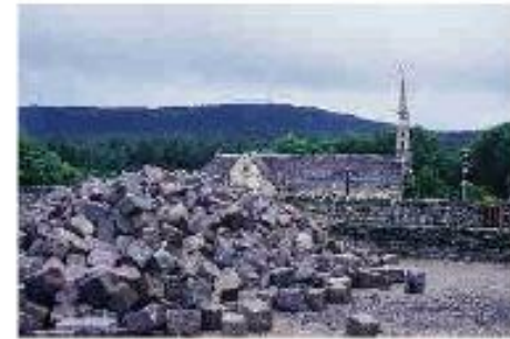
Chantier ar blasenn da c'houde Le chantier de la place ensuite
