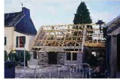
Chantier an ti-kêr da gentañ Le chantier de la Mairie d'abord
